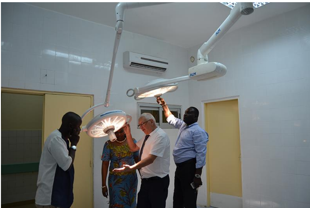
Contrôle du fonctionnement d'un éclairage opératoire suite à un don dans un hôpital sur Dakar.
